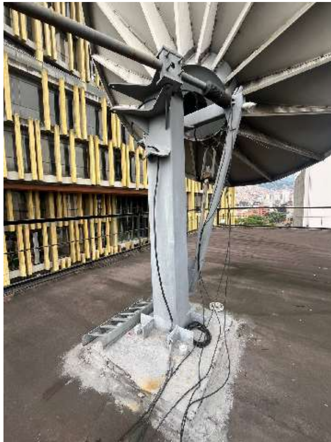
Antena Patriot 3.8 mts Prime Focus – Banda C polarización circular dos puertos
