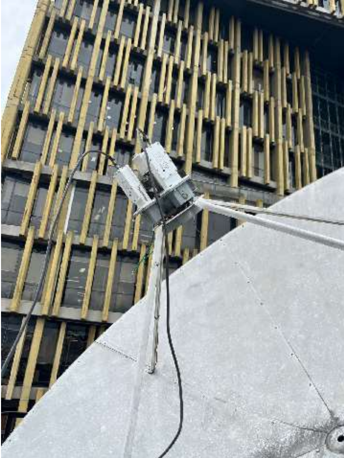
Antena RX Patriot 3.0 mts Prime Focus Alimentador polarización Lineal H-V Cuatro puertos Bandas C y Ku
