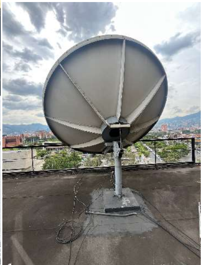
Antena RX Patriot 3.0 mts Prime Focus Alimentador polarización Lineal H-V Cuatro puertos Bandas C y Ku
