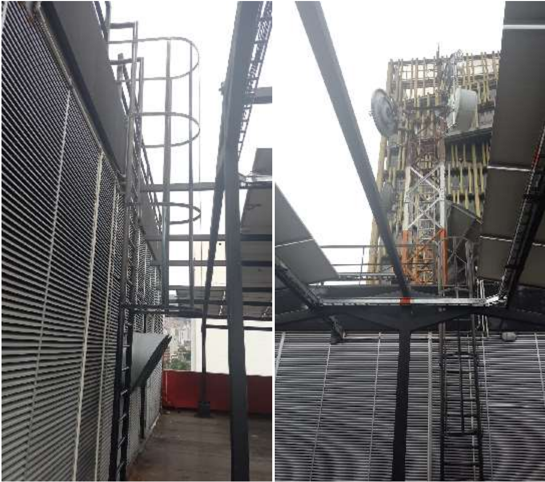
Escalerilla acceso terraza antenas Piso 5 Cubo Rojo
