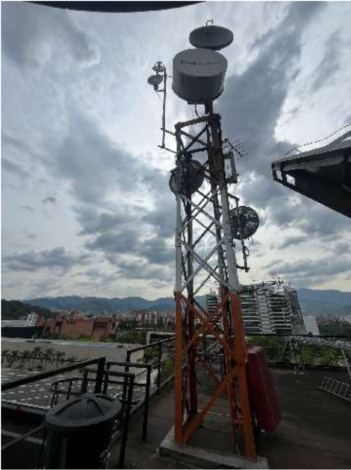
Detalle de la torre – cuadrada autosoportada 1m x 1m – 6 mts altura
