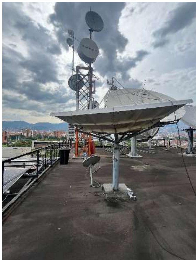
Antena Prodelin 3.0 mts Prime Focus alimentador Lineal Banda Ku
