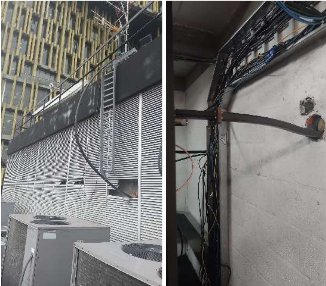
Detalle Guía de onda hacia antena principal
